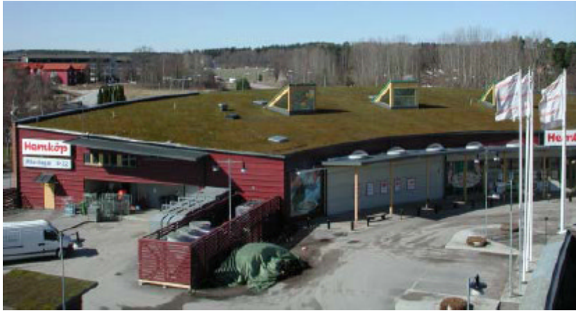
Figur 12. Exempel på ”grönt tak” på en matvaruaffär i köpcenter i Runby, Upplands Väsby. Foto: Oxunda Vattensamverkan.
